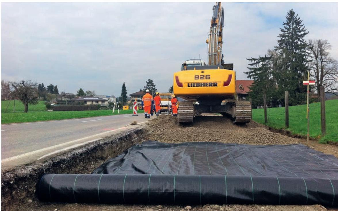
4 | Mindestanforderungen an ein Geotextil mit der Funktion Trennen [SN 670 241, Tab. 2].
