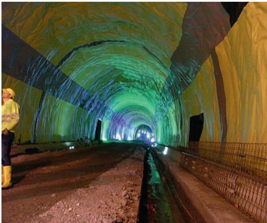
■ Bei den Baustellentests erfolgten Probeeinbauten am 1:1-Modell in Versuchsstollen.
